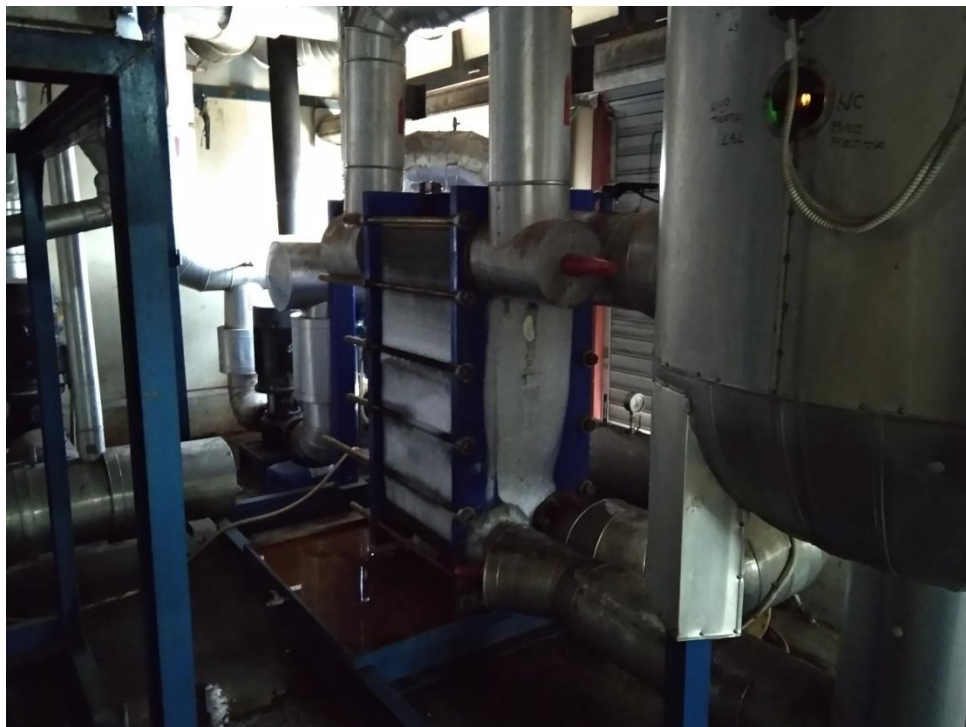
Slika 6. Pločasti izmjenjivači topline
