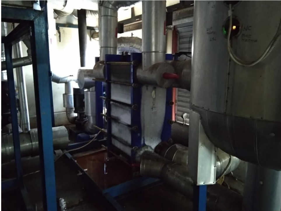
Slika 6. Pločasti izmjenjivači topline
