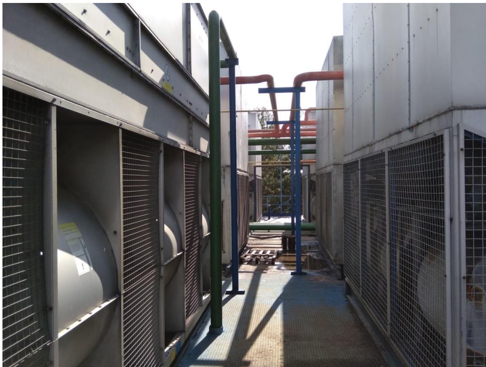
Slika 4. Evaporativni kondenzatori
