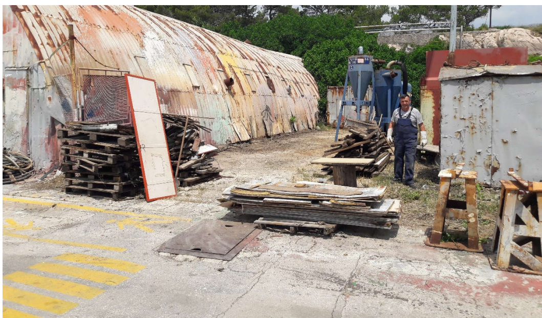
Slika 28. U tijeku faze sortiranja – hangari
