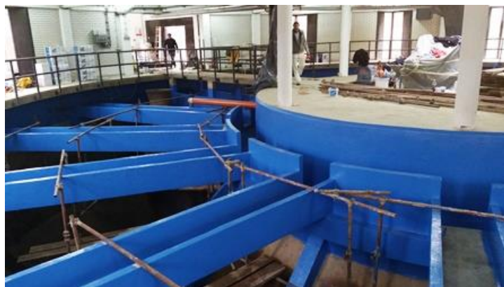
Slika 2.3 Prikaz remonta postrojenja [1]
