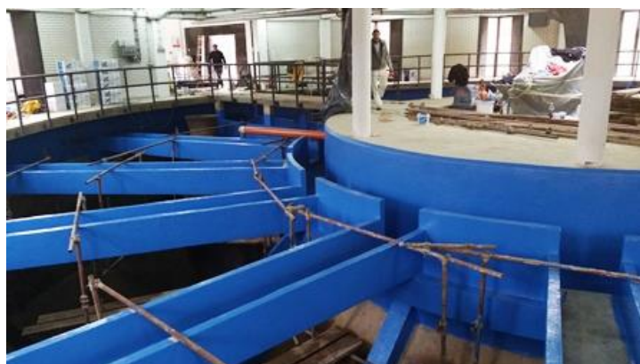
Slika 2.3 Prikaz remonta postrojenja [1]
