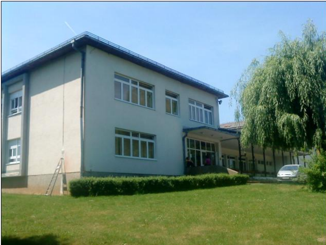
Sl.18. Pročelje Osnovne škole Eugena Kvaternika Rakovica
