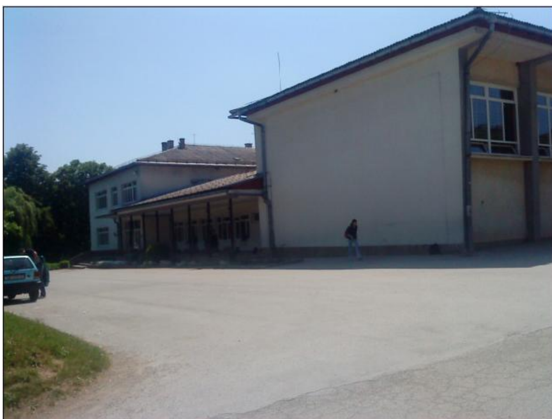
Sl.20. Školska zgrada s dvoranom
