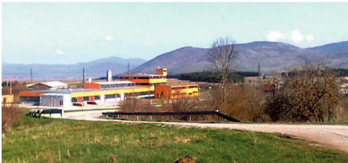
Slika 1. Kogeneracijsko postrojenje na šumsku biomasu u Udbini [2]
