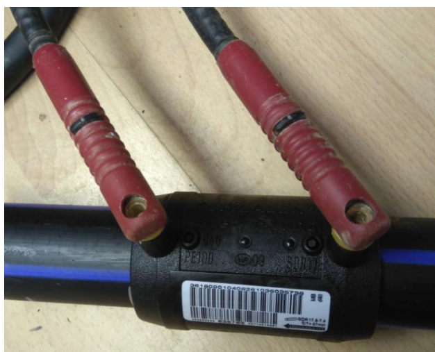
Slika 35. Elektrofuzijsko zavarivanje
