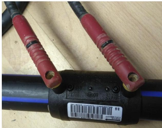
Slika 35. Elektrofuzijsko zavarivanje
