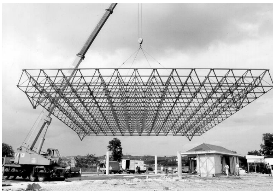
Slika 7. Prostorna rešetkasta konstrukcija (montaža) [8]
