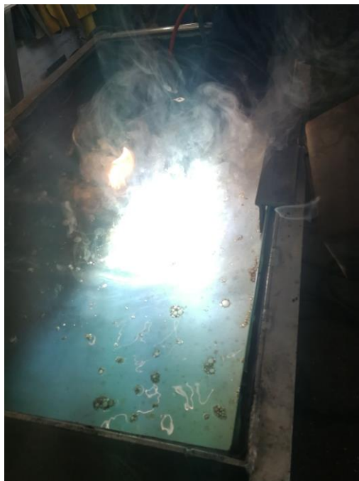
Slika 42. Zavarivanje pod vodom
