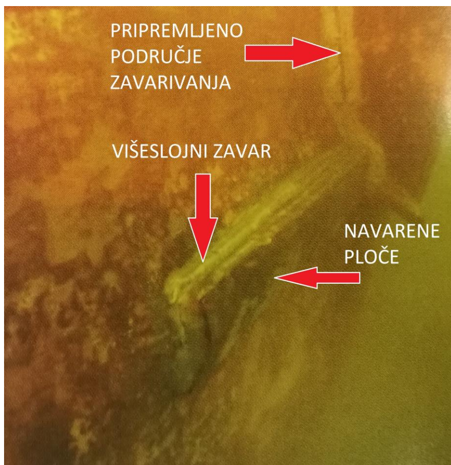
Slika 27. Stanje nakon izvršenih popravaka [15]
