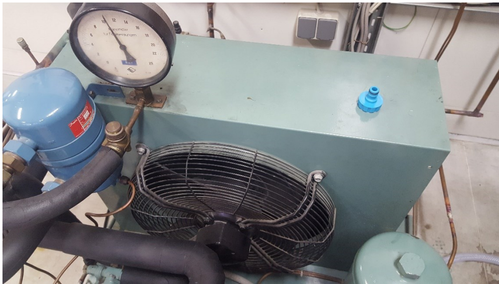
Slika 13. Kondenzator
