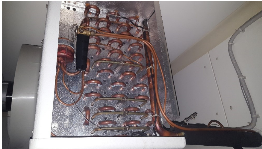
Slika 12. Isparivač
