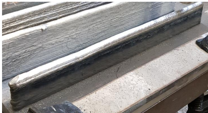
Slika 33. Nastavak izrade prvog zida nakon brušenja oštećenih slojeva
