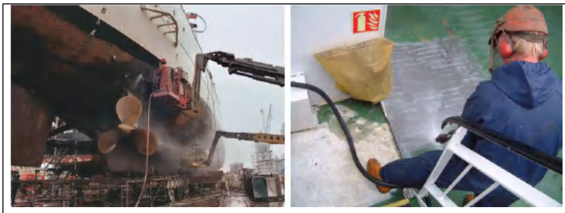
Slika 10. Priprema površine vodenim mlazom [6]
