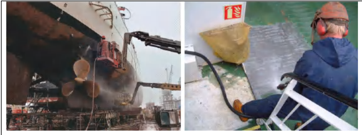
Slika 10. Priprema površine vodenim mlazom [6]
