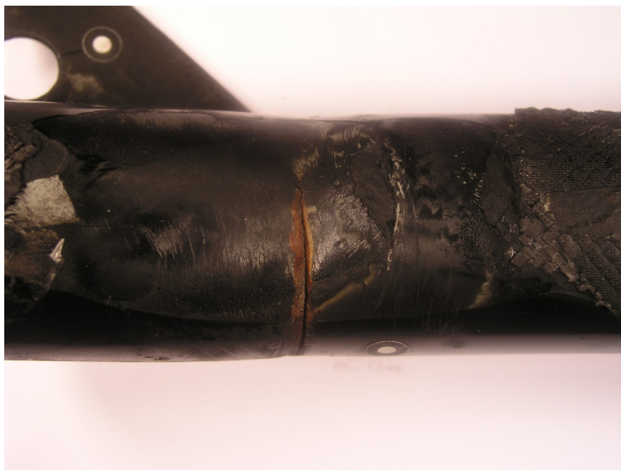
Slika 10. Pukotina na uzorku
