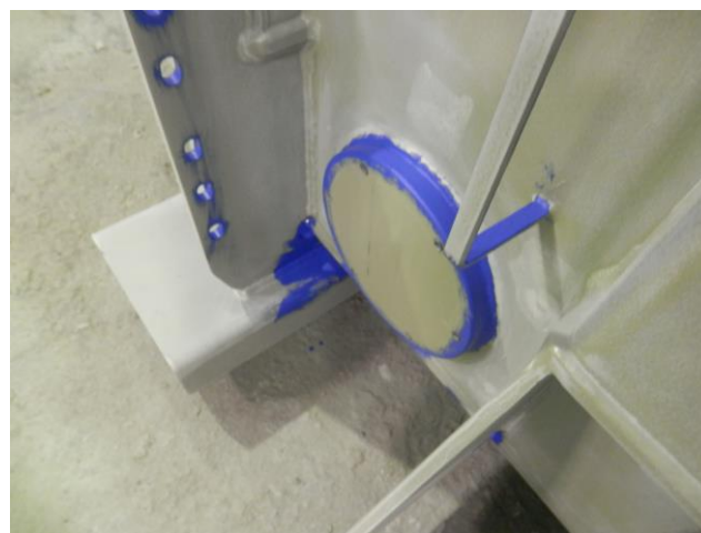
Slika 12. Nanešeni premaz na teško dostupna mjesta prije prskanja
