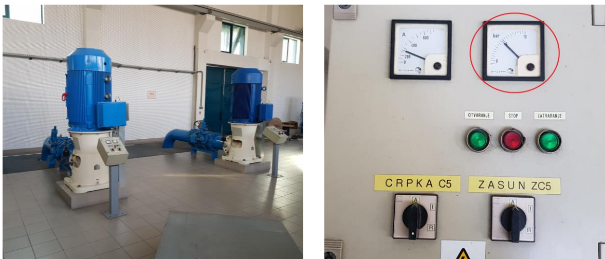
Slika 5.11 Sustav za crpljenje vode u vodoopskrbnu mrežu
