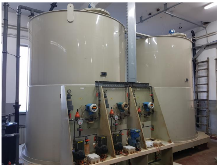
Slika 5.8 Sustav za doziranje flokulanta PAA
