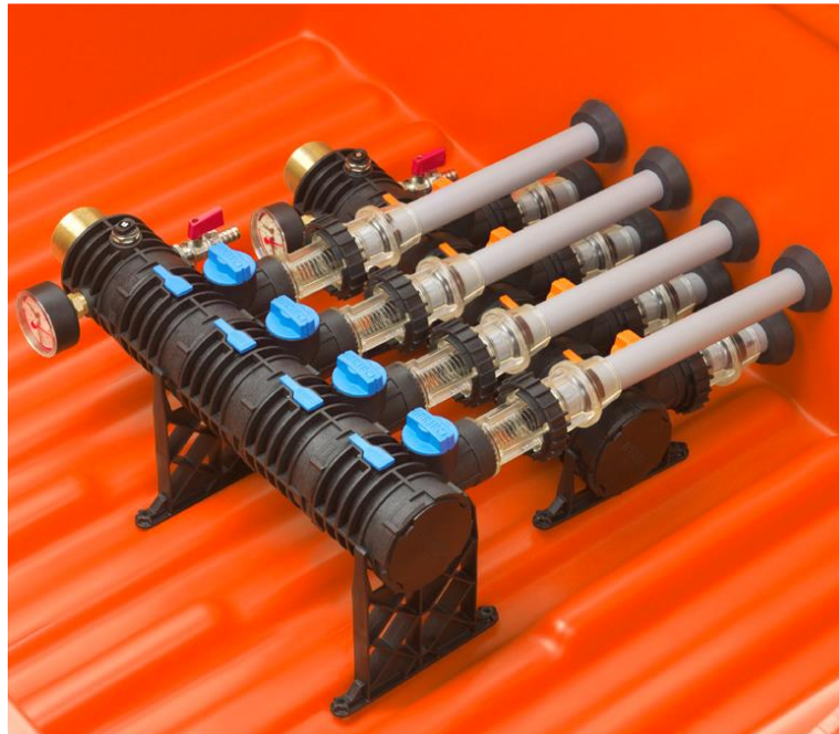
Slika 4.5 Razdjelnik primarnog kruga Click
