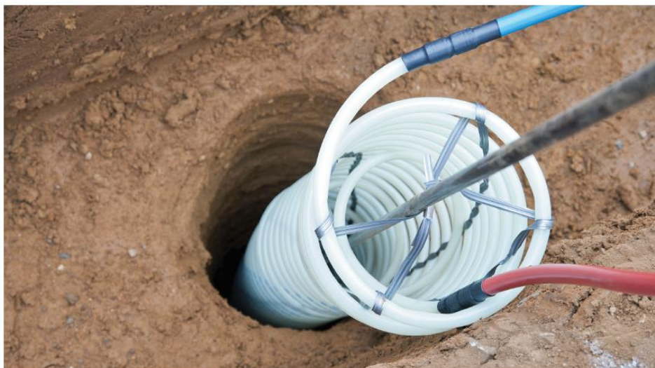
Slika 4.3 Helix sonda
