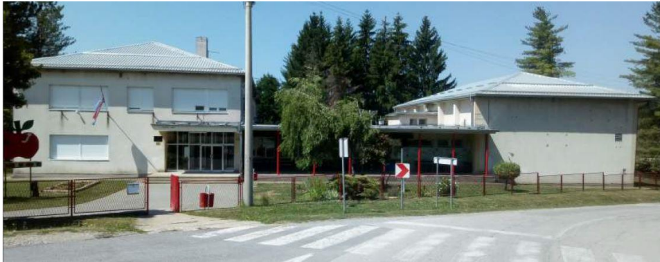
Slika 2.1 Pogled na sjeveroistočno (ulazno) pročelje građevine
