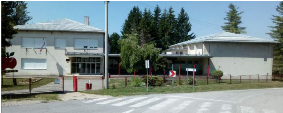
Slika 2.1 Pogled na sjeveroistočno (ulazno) pročelje građevine
