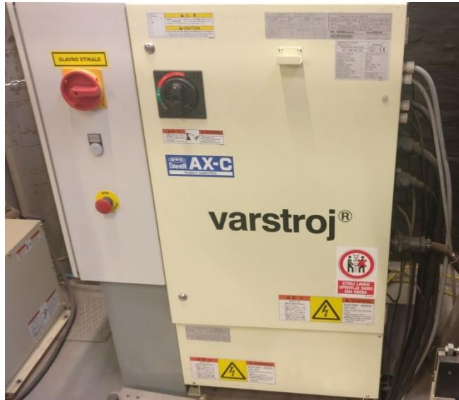
Slika 27. Električka i upravljačka jedinica AX-C
