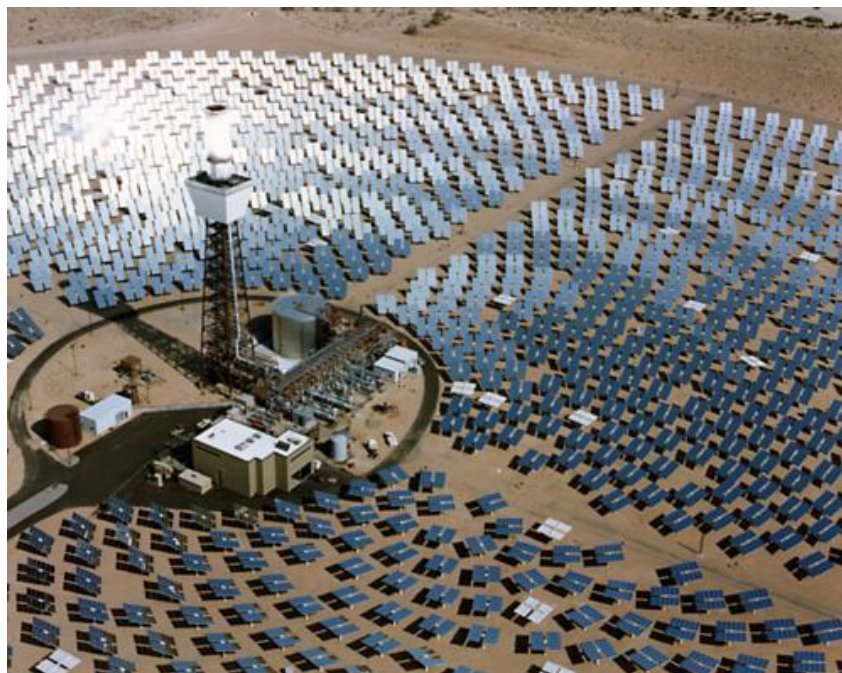
Slika 28. Centralni prijammnik na tornju i heliostatima
