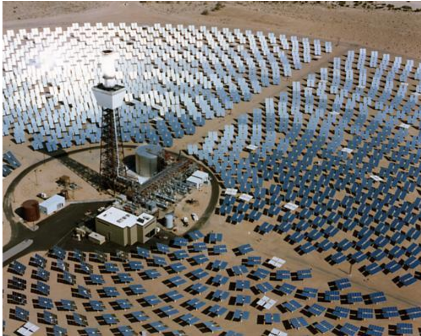
Slika 28. Centralni prijammnik na tornju i heliostatima
