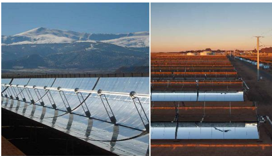
Slika 22. Parabolični žljebasti kolektori [9]
