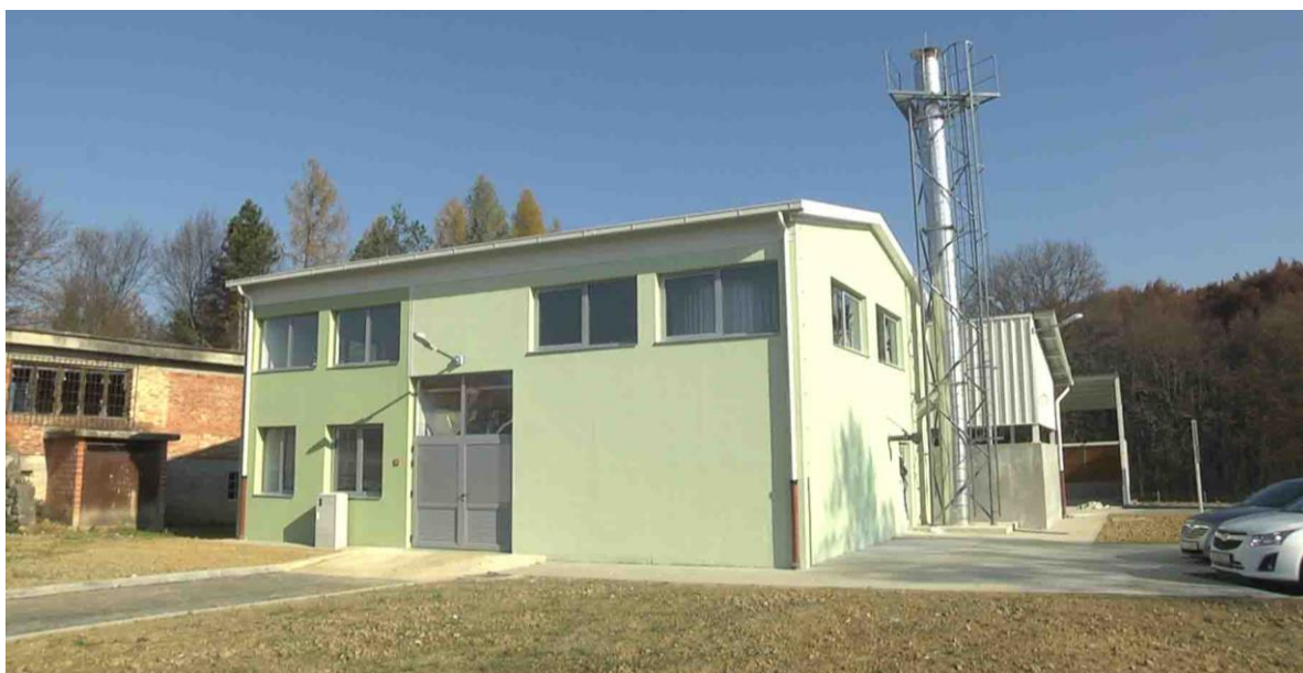
Slika 4 Toplana na biomasu u Pokupskom snage 1 MW [30]
