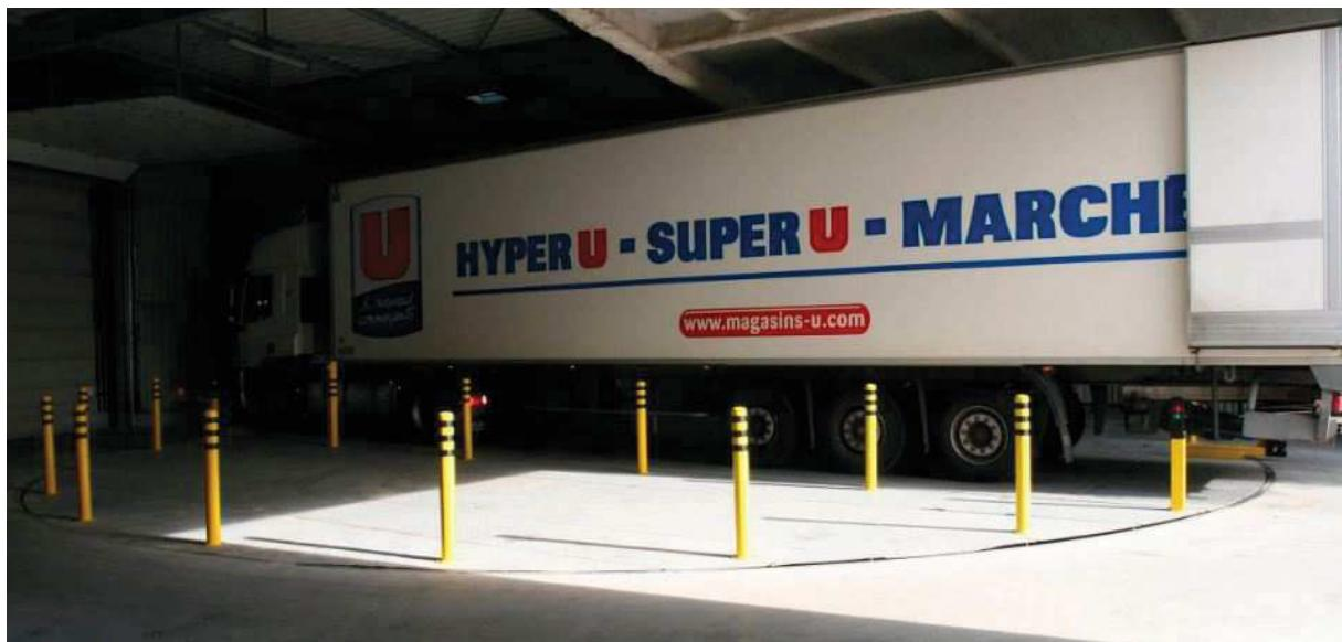
Slika 2 Rotacijska platforma za tegljače [1]
