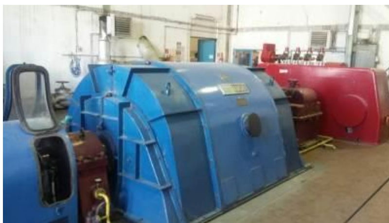
Slika 21. Parna turbina u energani tvornice šećera [10]
