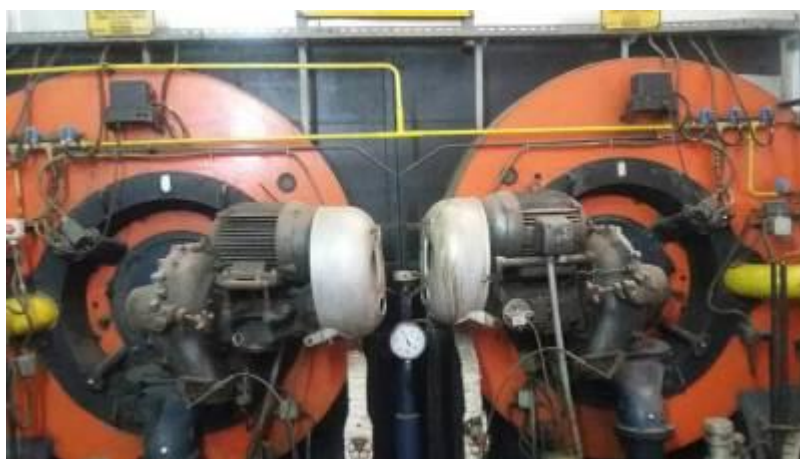
Slika 20. Gorionici u energani tvornice šećera [10]
