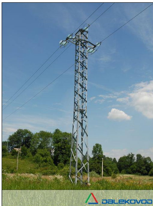
Slika 2.3. Nosivi stup [7]
