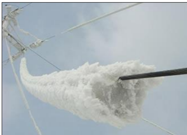
Slika 2.8. Dodatni teret na vodičima dalekovoda u eksploataciji [12]
