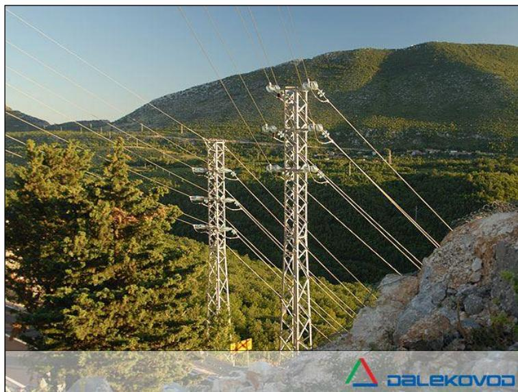
Slika 2.4. Zatezni stup [8]
