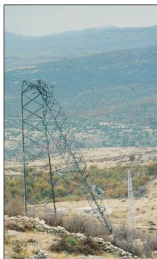
Slika 6.1. Kolaps stupa uslijed ekstremnog opterećenja vjetrom [24]
