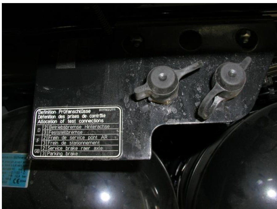
Slika 1. Kontrolni priključci za spajanje manometra
