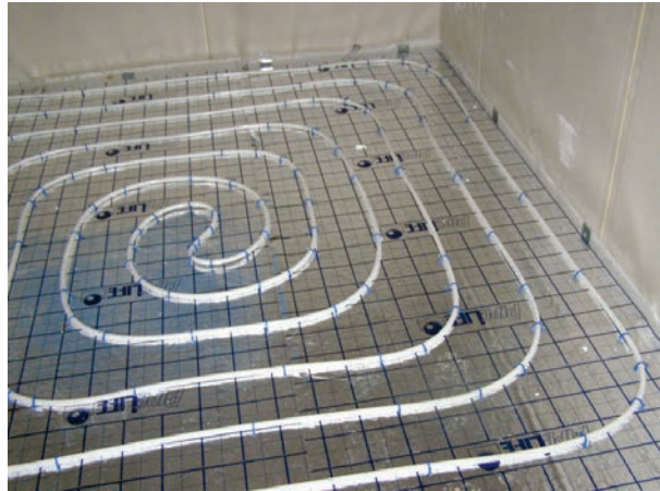
Slika 6: Petlja podnog grijanja [15]
