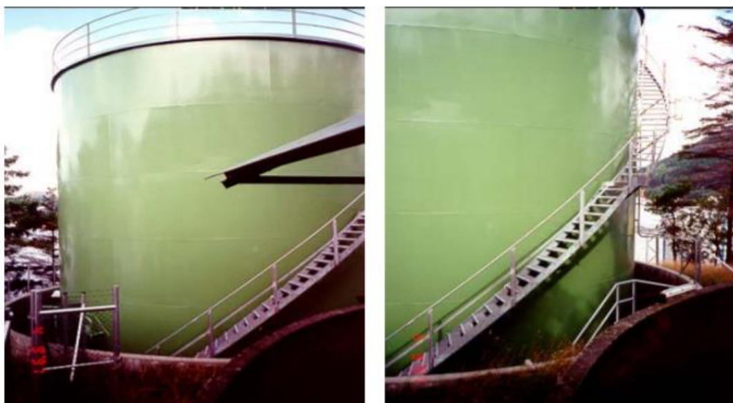
Slika 11. Hibridni završni vodorazrjedivi premaz nakon 8 godina [38]
