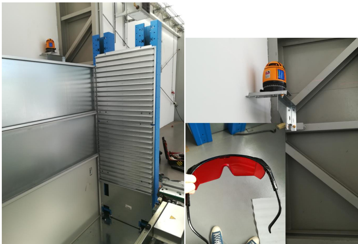
Slika 32. Postupak niveliranja Shuttle sustava
