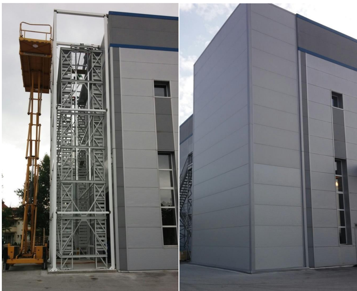
Slika 12. Izvedba VLM sustava kao samonosive jedinice [3]
