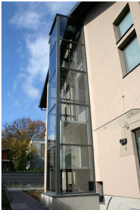
Slika 18 Prikaz oslonjenog fasadnog dizala sa staklenom ispunom
