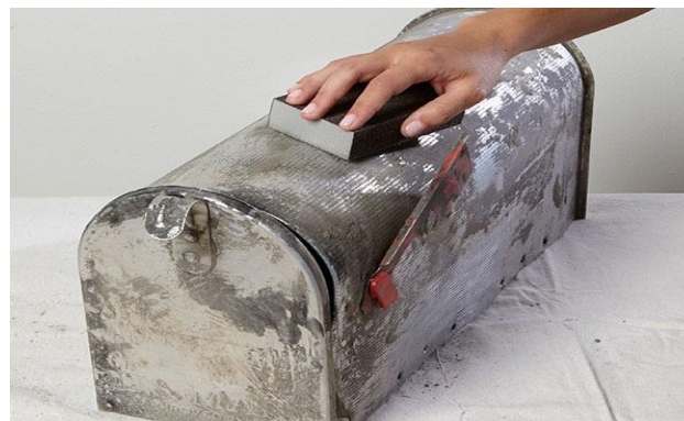
Slika 2. Ručno mehaničko čišćenje metalnog sandučića [10]
