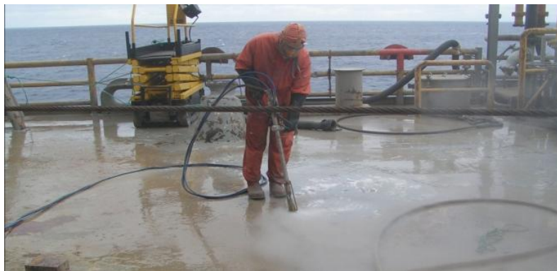
Slika 4. Čišćenje vodenim mlazom [12]
