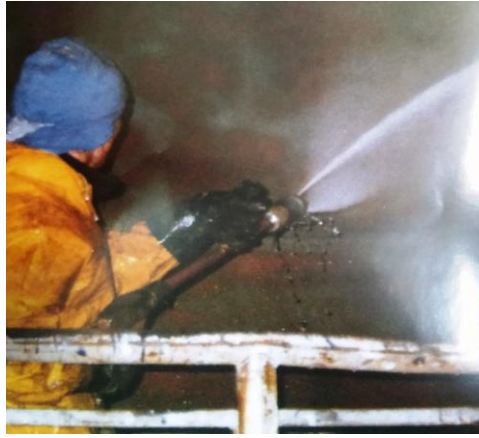
Slika 1. Ispiranje površine broda [9]
