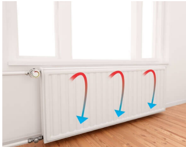
Slika 6. Pravilan smještaj pločastog radijatora
