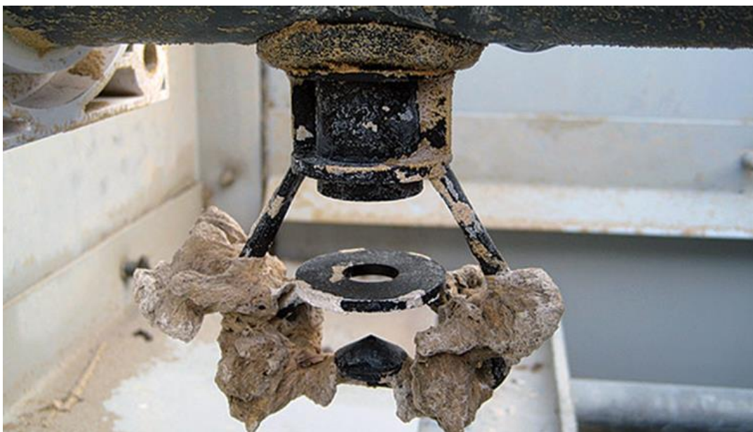
Slika 15. Nečistoće na mlaznici
