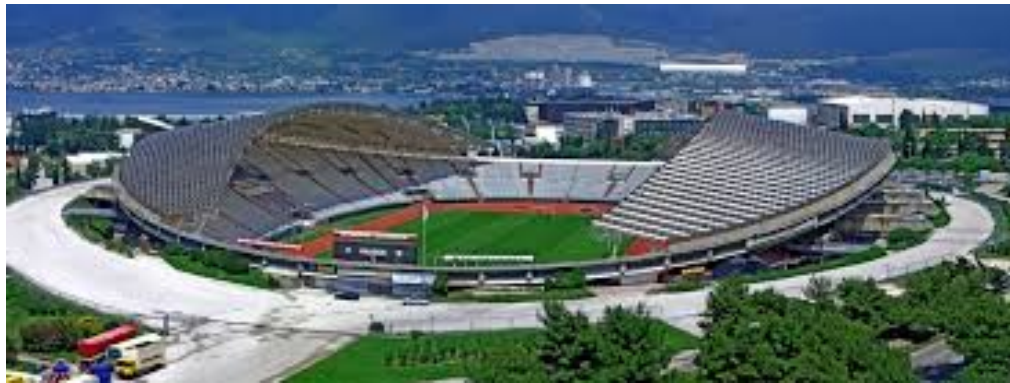
Slika 3: Primjeri klase izvedbe EXC3 [9,10,11]
