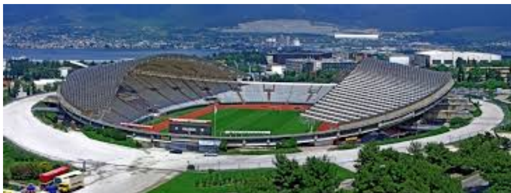
Slika 3: Primjeri klase izvedbe EXC3 [9,10,11]
