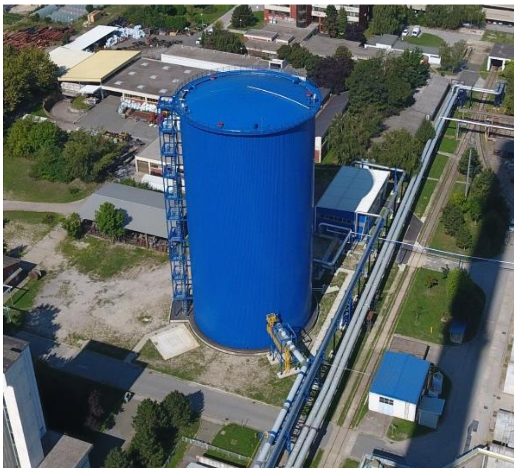
Slika 7. Toplinski akumulator TE-TO Zagreb; [17]
