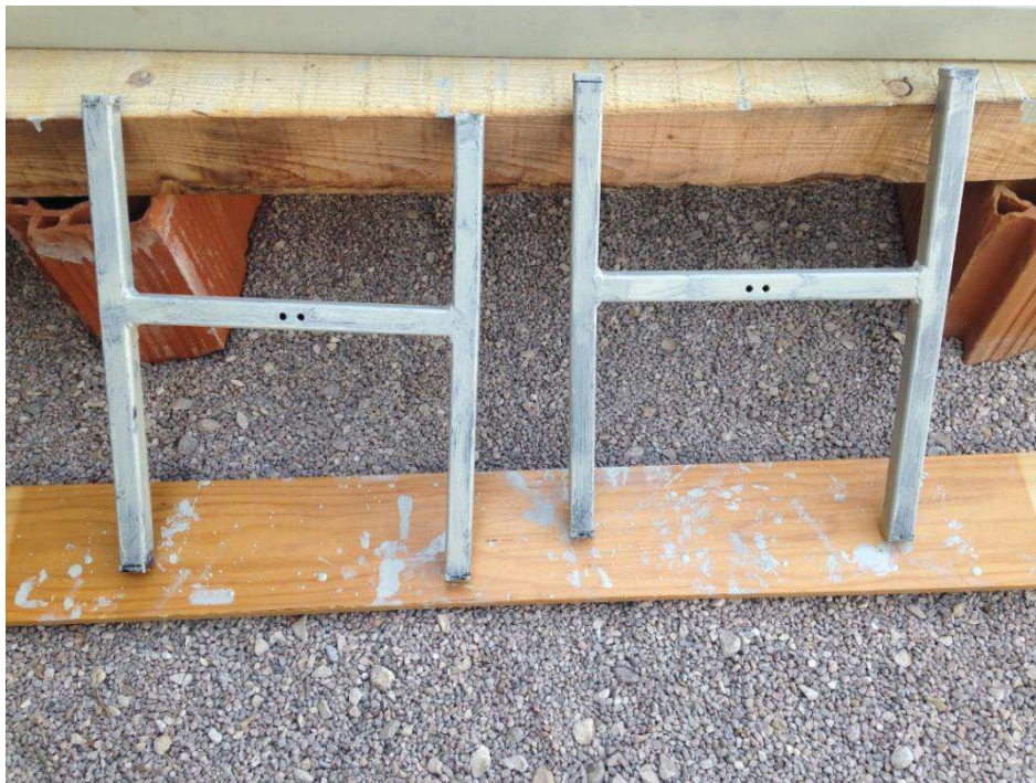
Slika 22. Prvi sloj dvokomponentnog epoksidnog temelja
