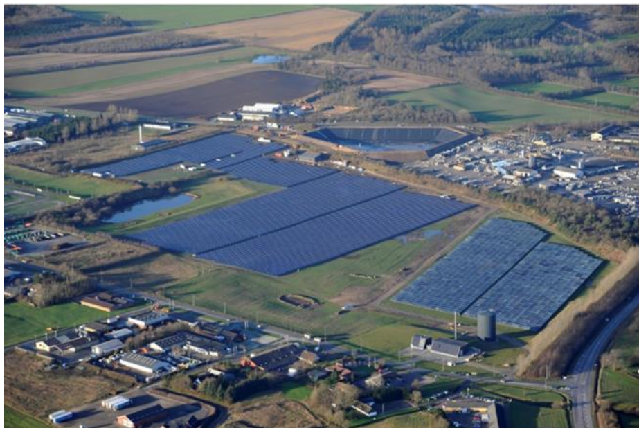
Slika 3 Solarni centralizirani toplinski sustav u Vojensu (Danska) [15]
