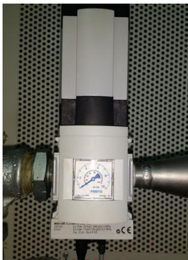
Slika 4.17 Regulator tlaka zraka
