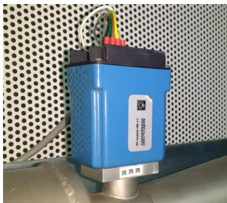
Slika 4.18 Senzor masenog protoka zraka
