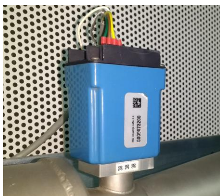
Slika 4.18 Senzor masenog protoka zraka
