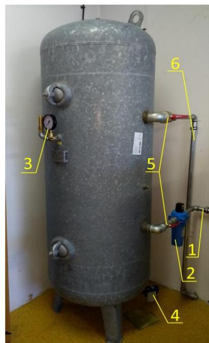
1 – dobavna cijev iz kompresora, 2 – odvlaživač zraka, 3 – manometar, 4 – uređaj za skupljanje kondenzata, 5 – sigurnosni ventil, 6 – cijev prema ispitnoj kabini
