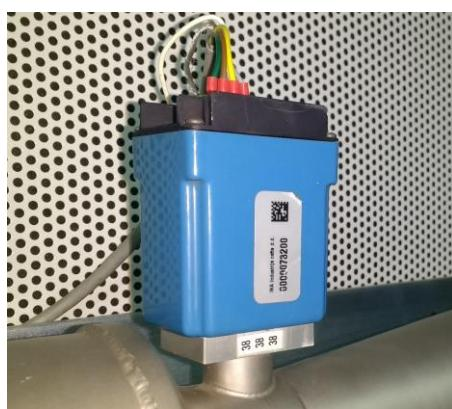
*Slika 4.18 Senzor masenog protoka zraka*
