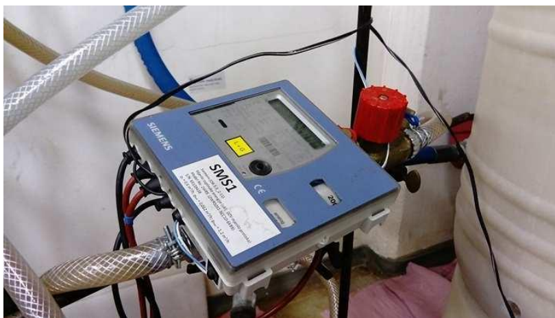
Slika 34 – Ultrazvučni protokomjer
