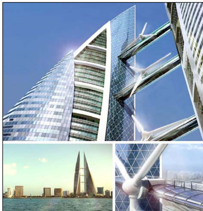
Slika 7.3. Prva građevina s instaliranim vjetroturbinama (3)
