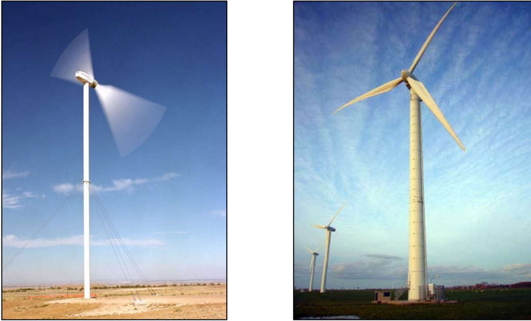
Slika 3.1. Izvedba sa stupom ispred lopatica i izvedba sa stupom iza lopatica
