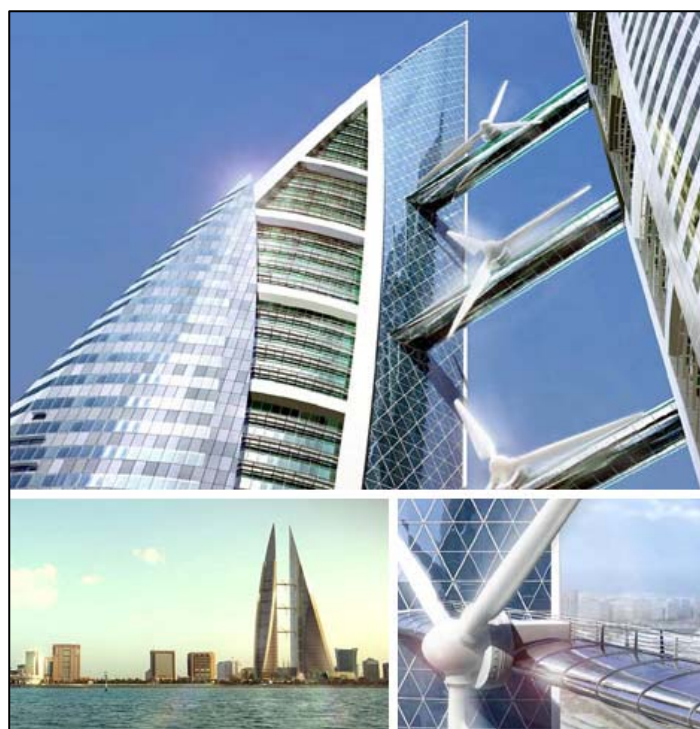
Slika 7.3. Prva građevina s instaliranim vjetroturbinama (3)
