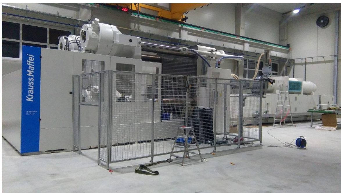
Slika 46. Montaža ograde i postolja
