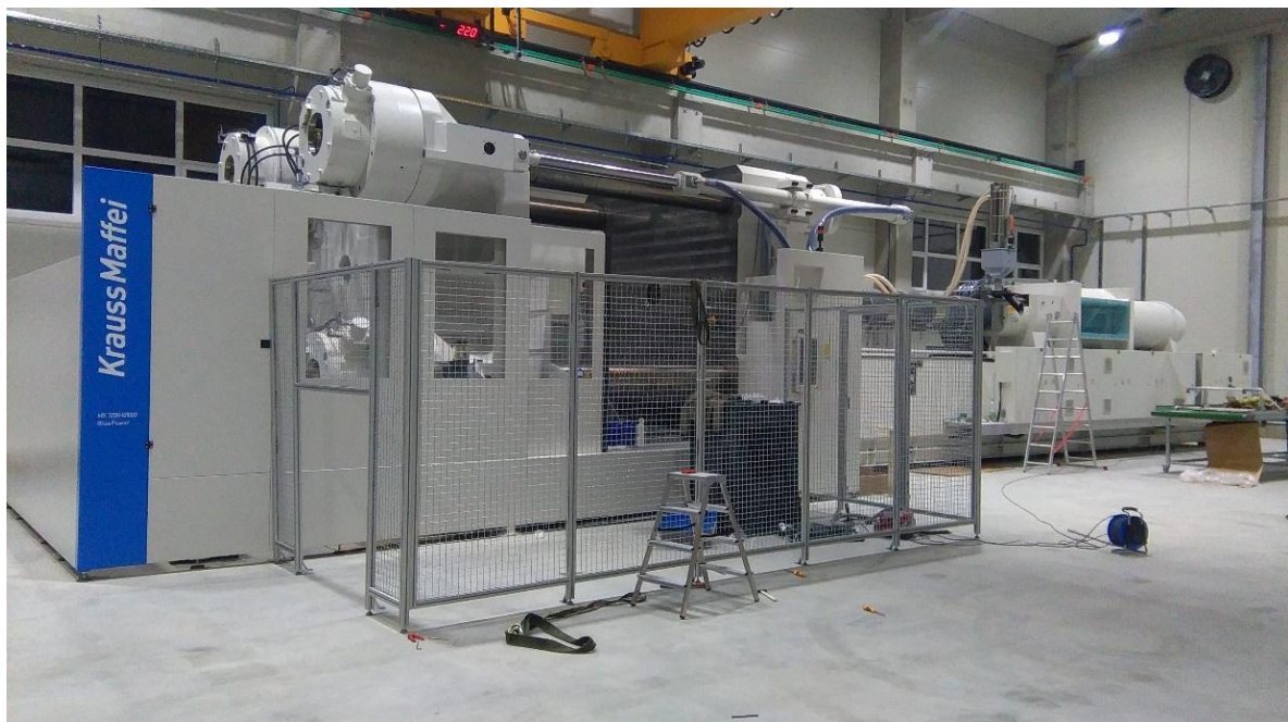
Slika 46. Montaža ograde i postolja
